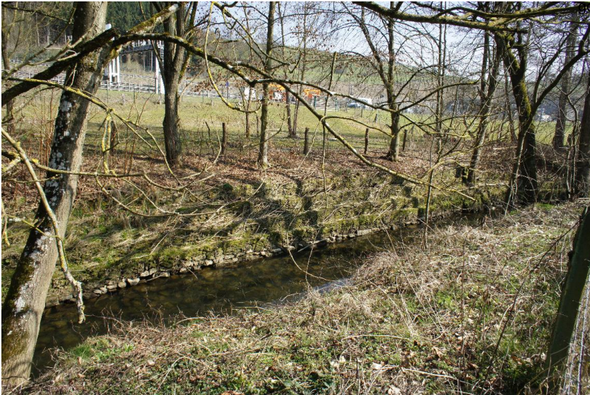
Uferverbau Steinsatz unverfugt
