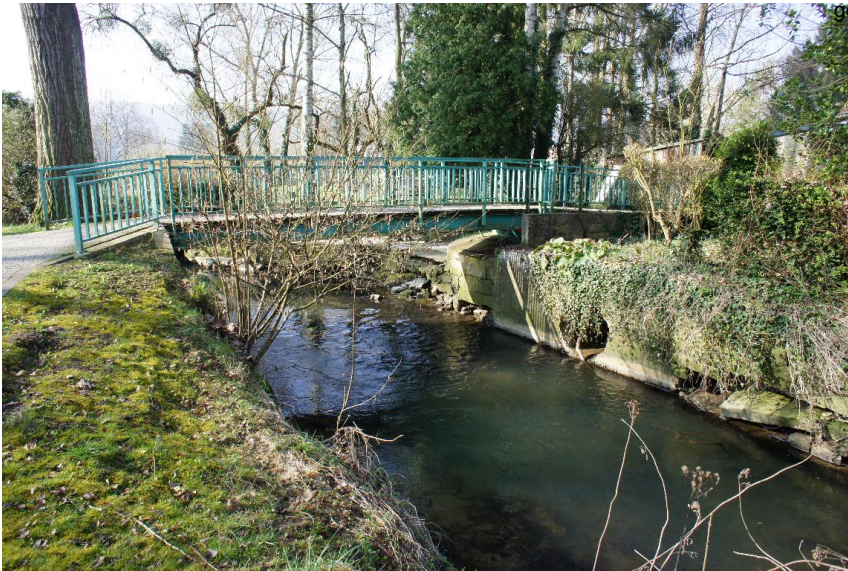
Einleitung - Durchlass; Ufer unterbrochen
