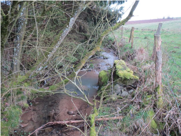
verrohrt bzw. ueberdeckt
