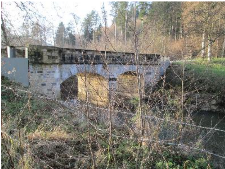
Durchlass; Ufer unterbrochen
