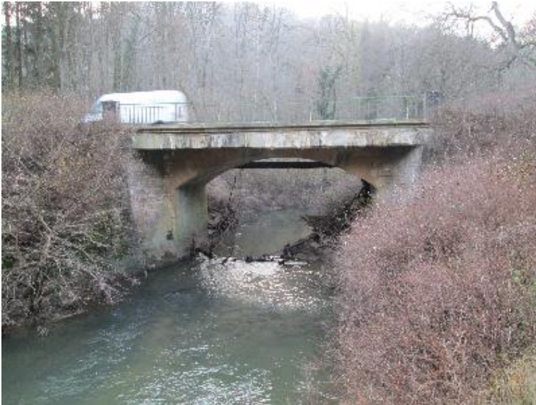
Durchlass; Ufer unterbrochen
