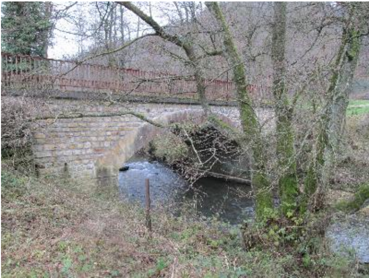
Durchlass; Ufer unterbrochen
