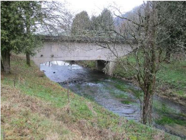
Durchlass; Ufer unterbrochen - Raue Gleite
