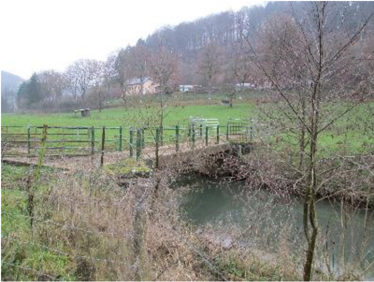
Durchlass; Ufer unterbrochen
