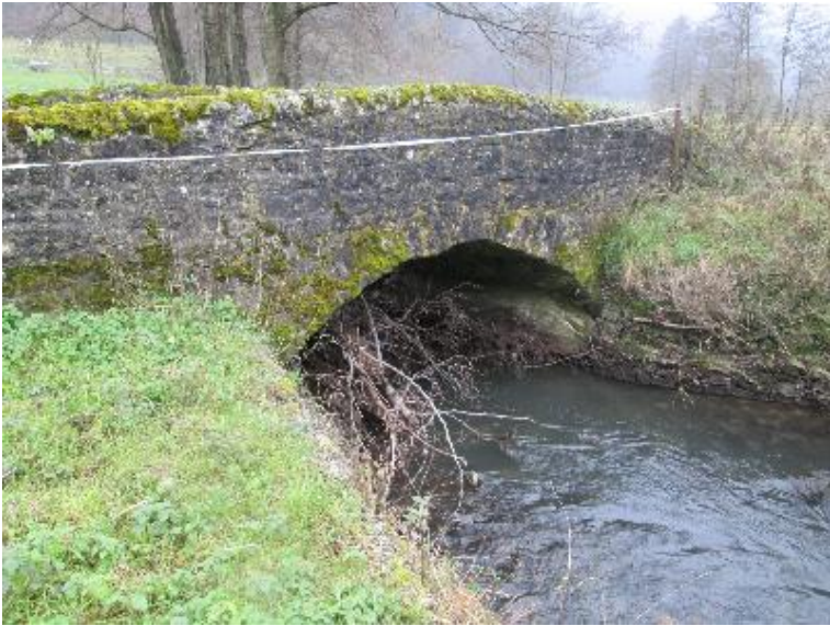
Durchlass; Ufer unterbrochen
