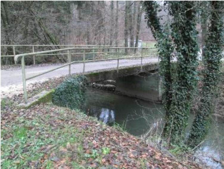
Durchlass; Ufer unterbrochen
