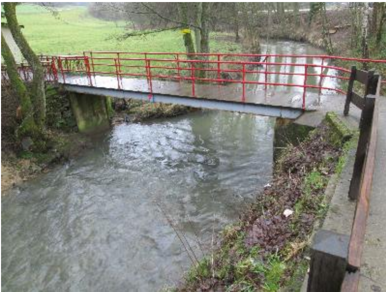
Raue Gleite - Durchlass; Ufer unterbrochen
