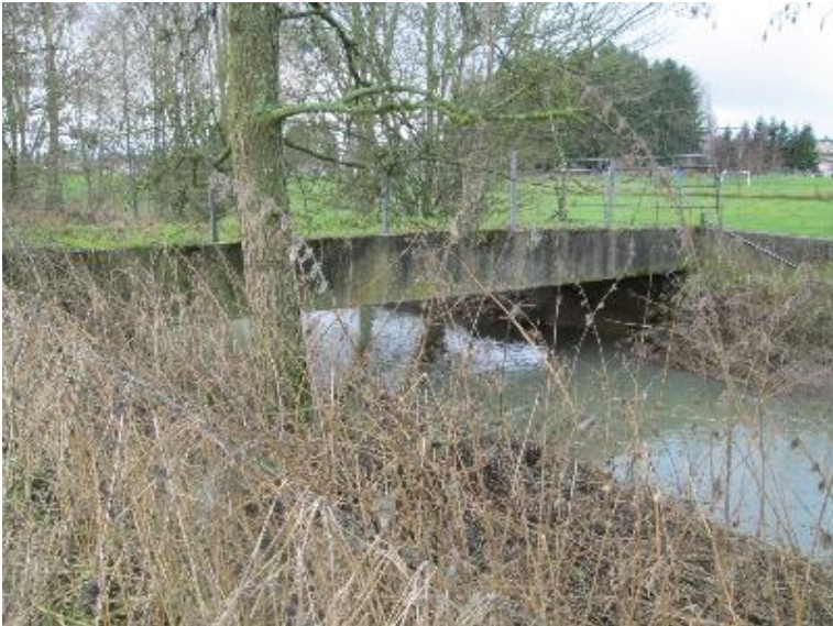
Durchlass; Ufer unterbrochen
