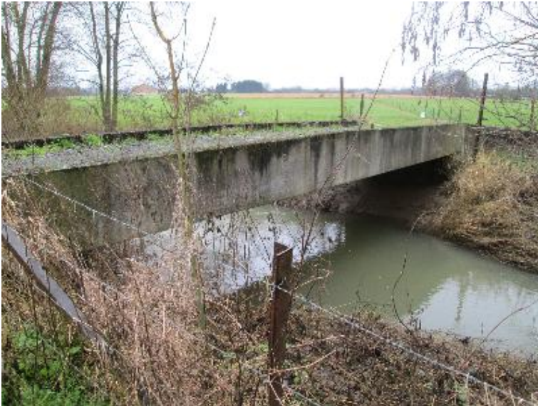
Durchlass; Ufer unterbrochen
