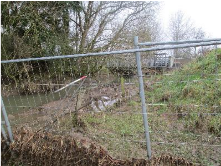
Durchlass; Ufer unterbrochen
