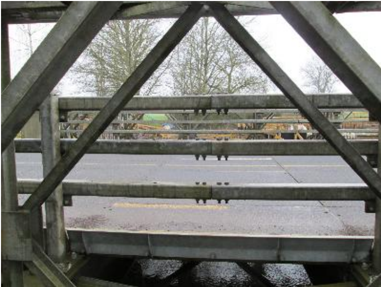
Durchlass; Ufer unterbrochen
