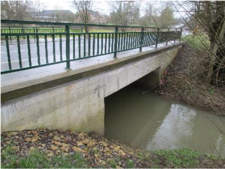
Durchlass; Ufer unterbrochen
