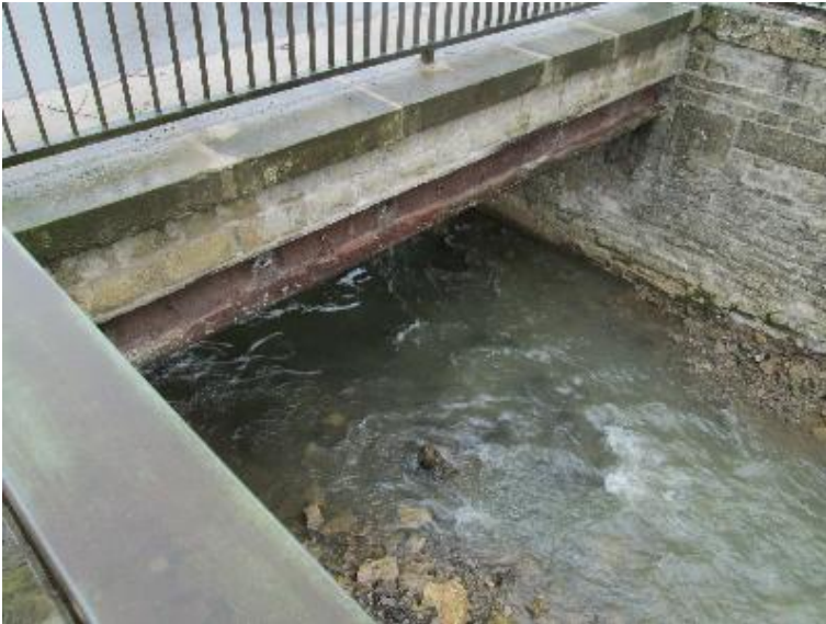
Durchlass; Ufer unterbrochen - Raue Gleite
