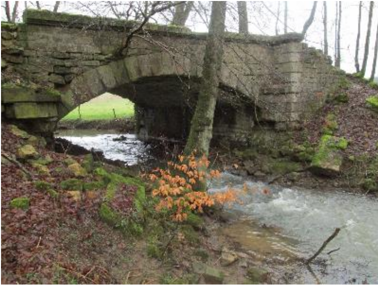
Durchlass; Ufer unterbrochen - Raue Rampe
