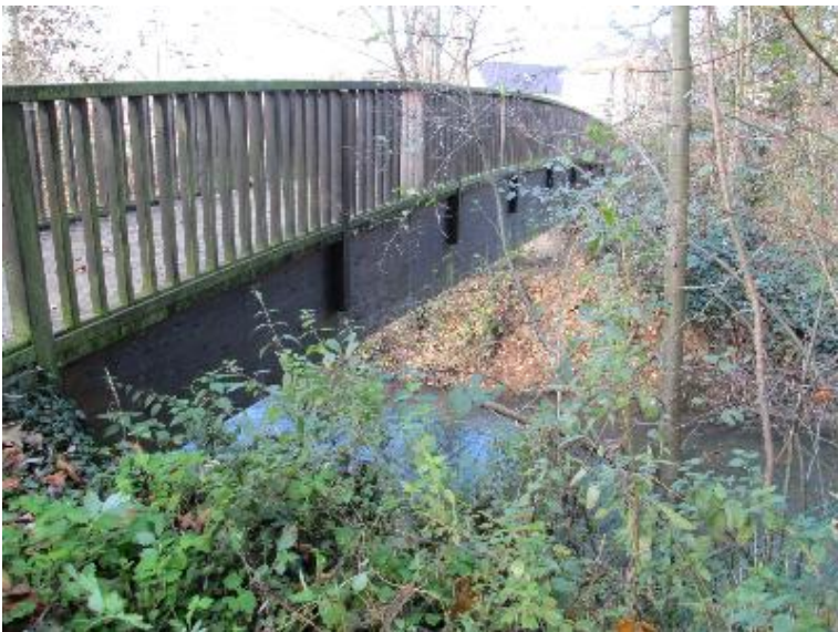
Durchlass; nicht strukturschädlich
