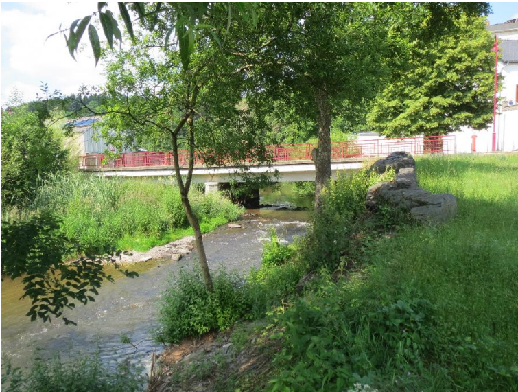
Durchlass; Ufer unterbrochen
