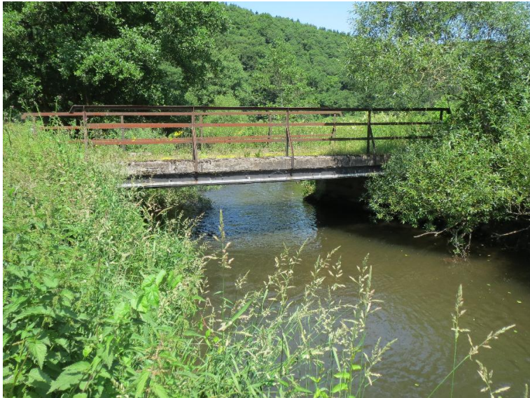
Durchlass; Ufer unterbrochen
