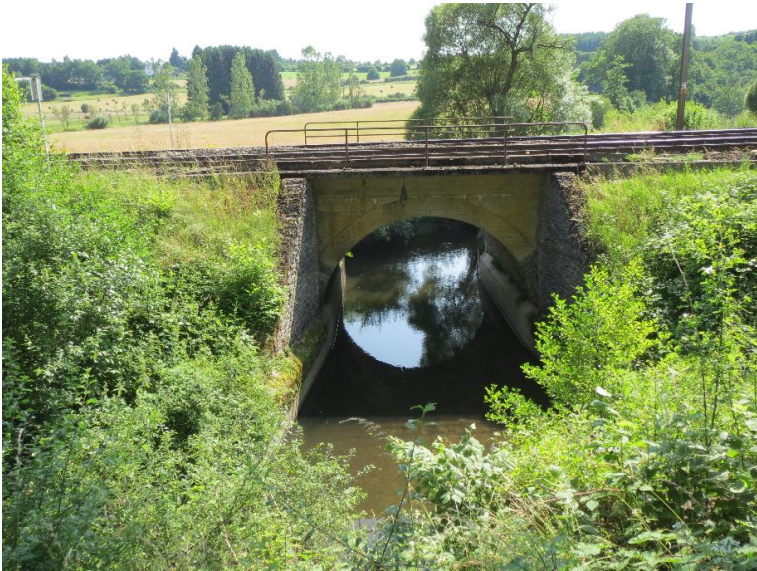
Durchlass; Ufer unterbrochen
