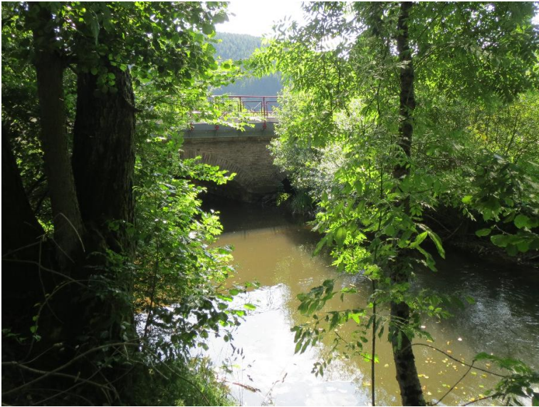
Durchlass; Ufer unterbrochen
