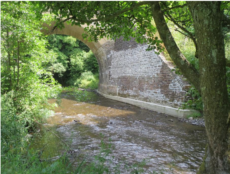
Durchlass; Ufer unterbrochen
