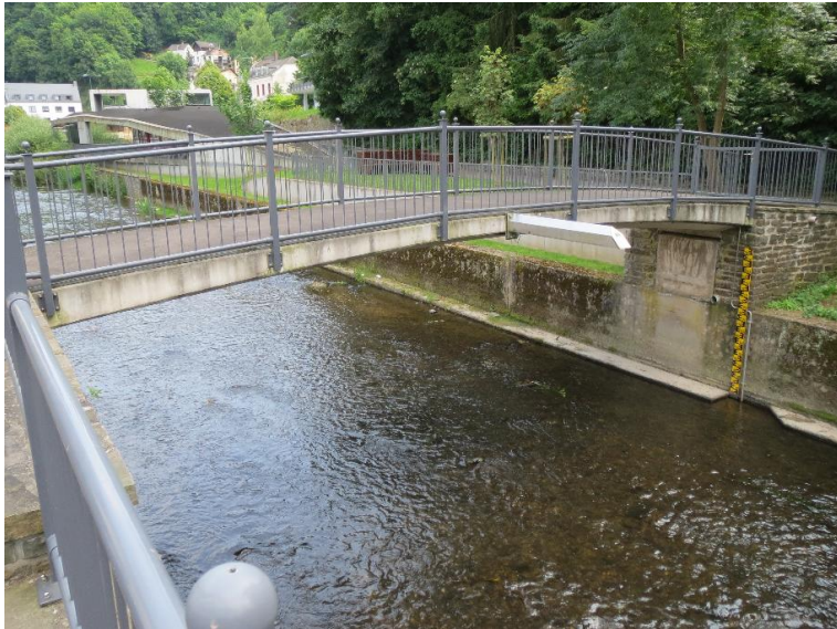
Durchlass; Ufer unterbrochen
