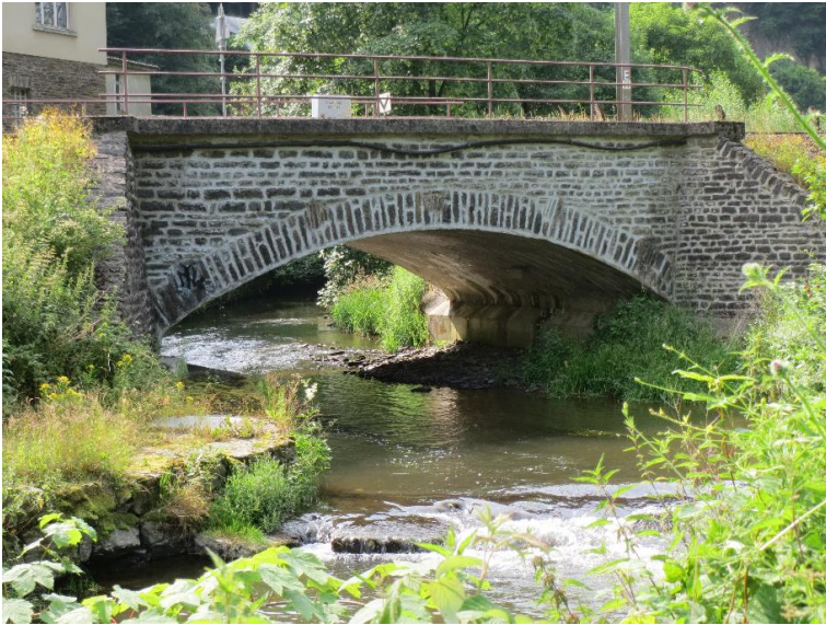
Durchlass; Ufer unterbrochen
