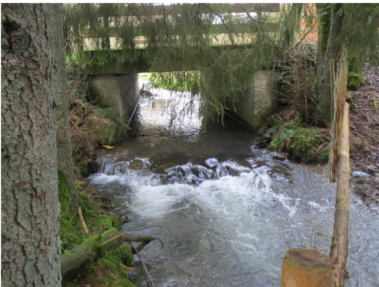
Absturz; kleiner - Durchlass; Ufer unterbrochen
