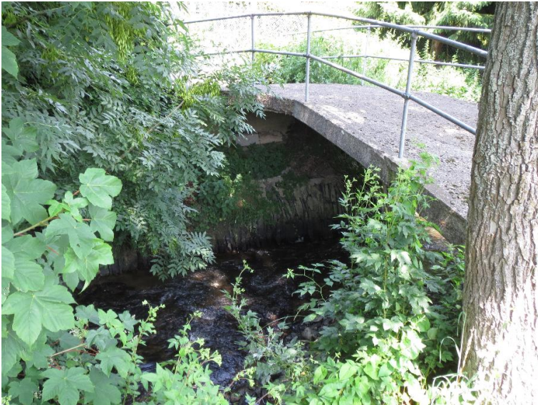
Durchlass; Ufer unterbrochen
