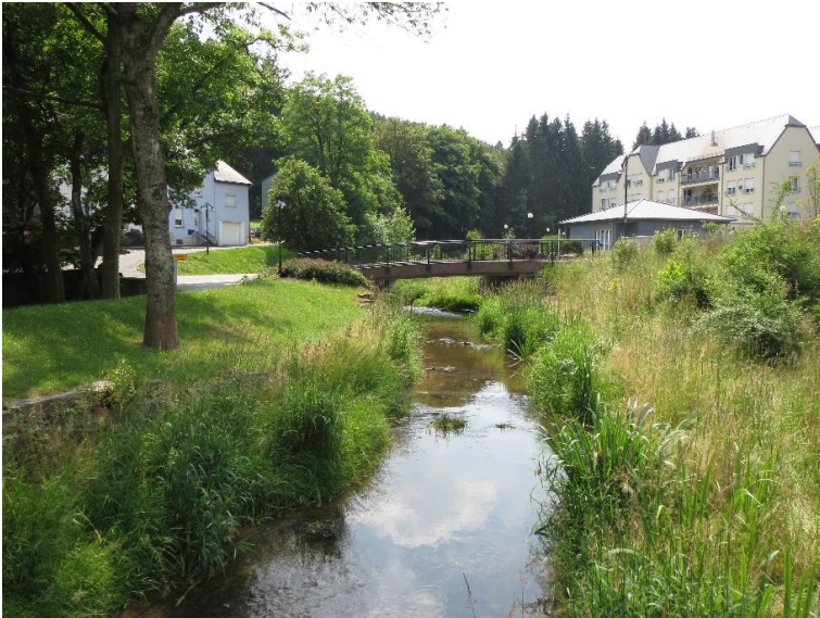
Durchlass; Ufer unterbrochen
