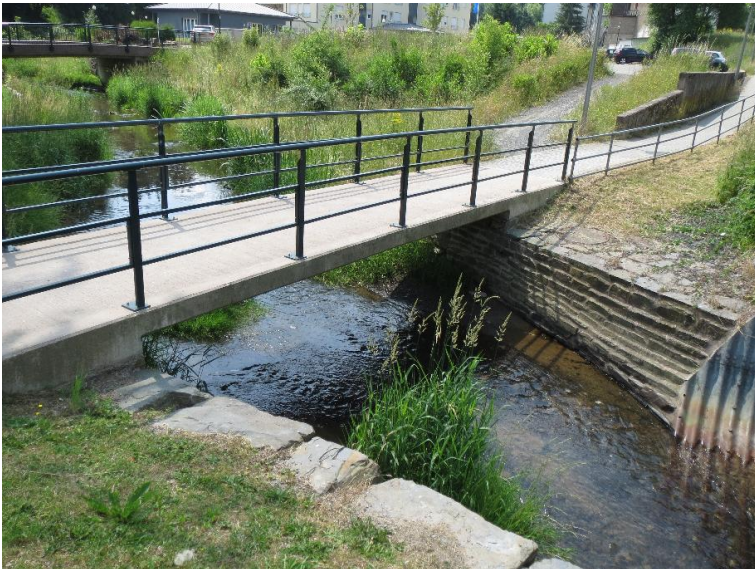
Durchlass; Ufer unterbrochen
