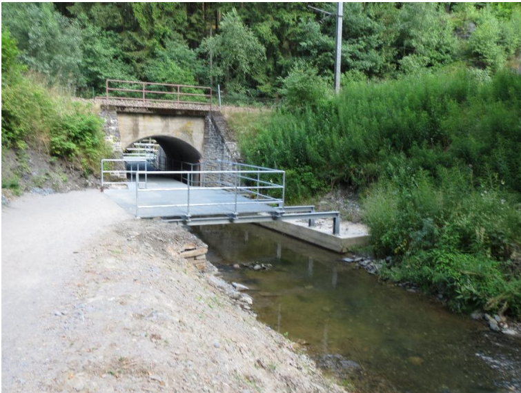
Durchlass; Ufer unterbrochen
