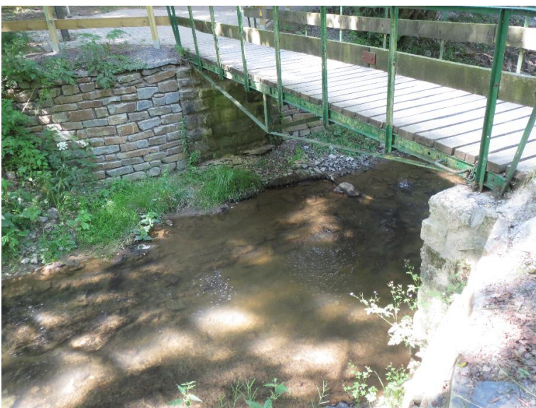
Durchlass; Ufer unterbrochen
