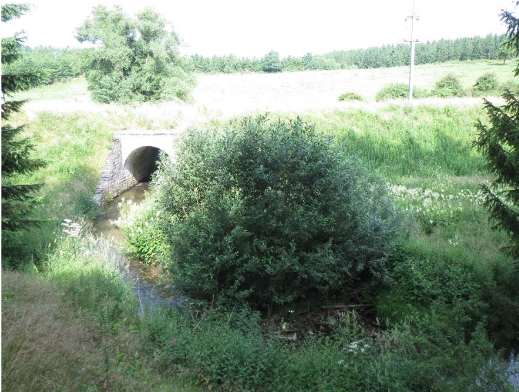
Durchlass; Ufer unterbrochen - Totholzverkläuserung
