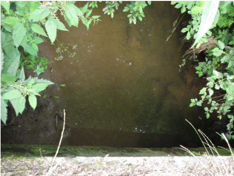
Durchlass; Ufer unterbrochen
