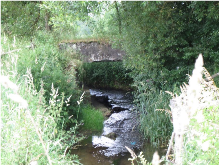
Durchlass; Ufer unterbrochen
