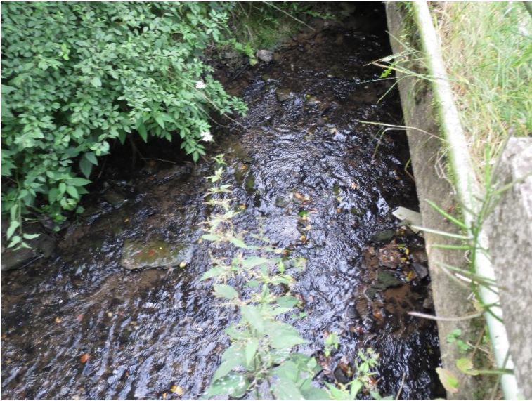
Durchlass; Ufer unterbrochen
