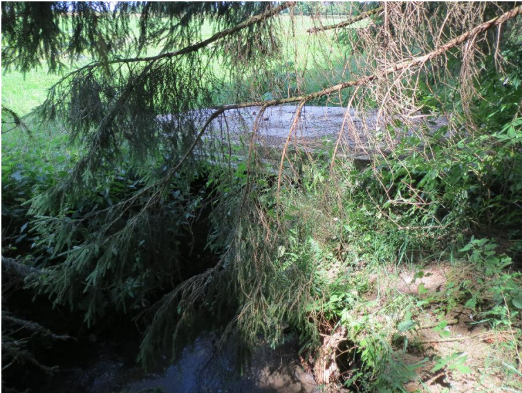
Durchlass; Ufer unterbrochen
