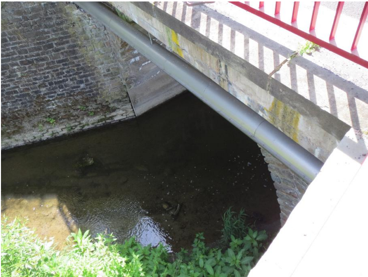
Durchlass; Ufer unterbrochen
