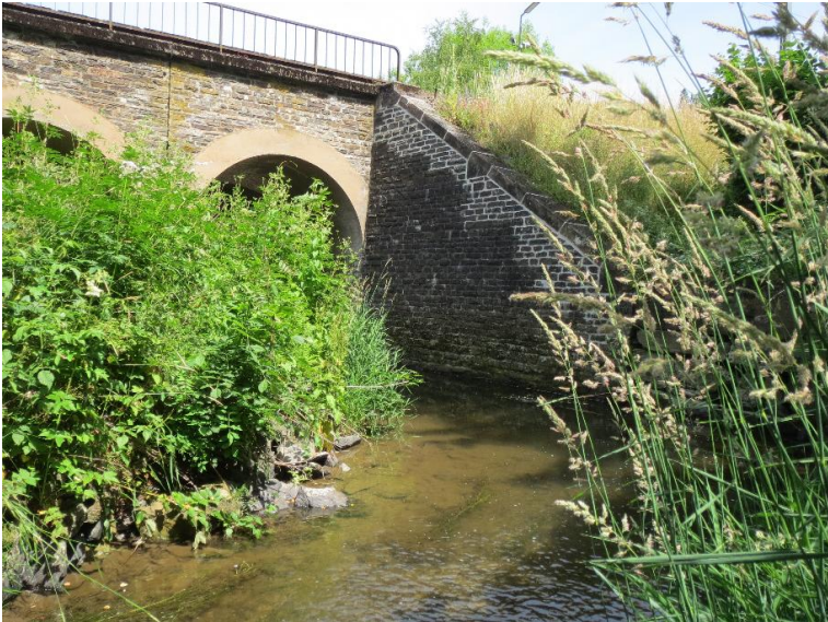
Durchlass; Ufer unterbrochen
