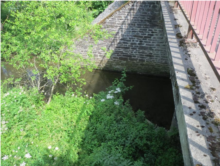
Durchlass; Ufer unterbrochen
