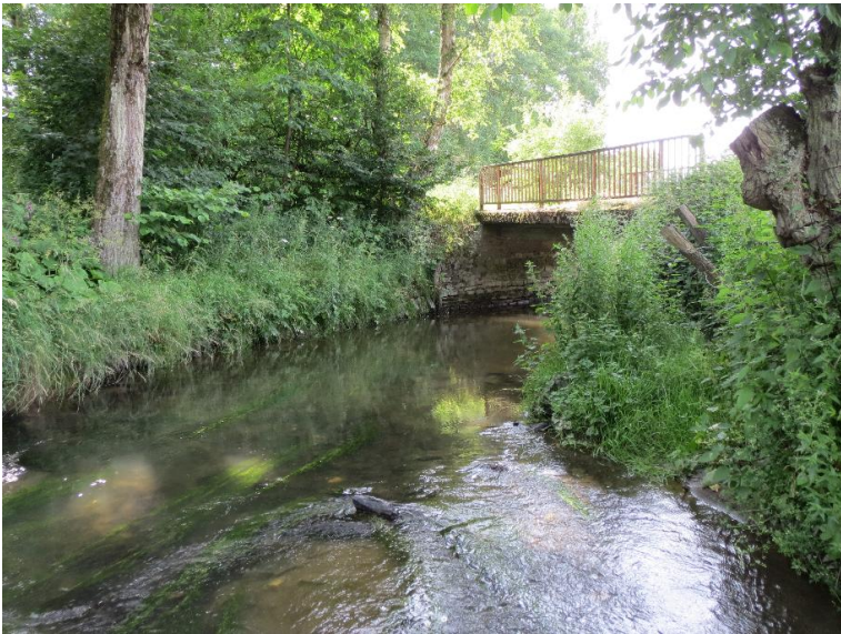
Durchlass; Ufer unterbrochen
