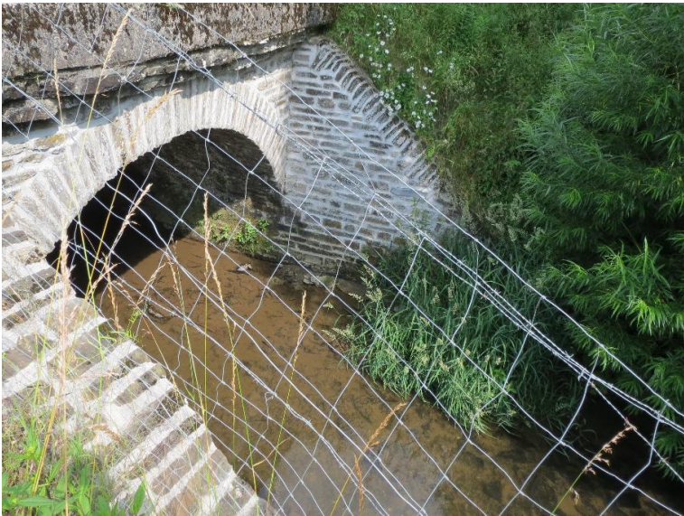
Durchlass; Ufer unterbrochen
