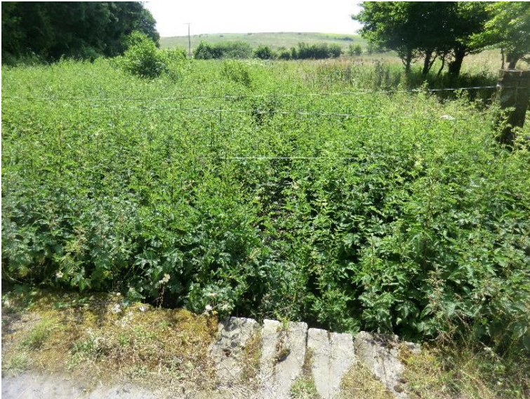
Durchlass; Ufer unterbrochen
