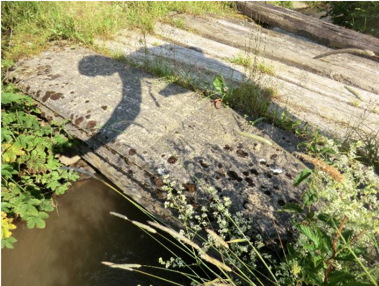
Durchlass; Ufer unterbrochen
