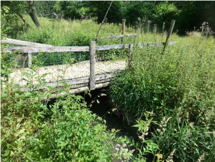
Durchlass; Ufer unterbrochen
