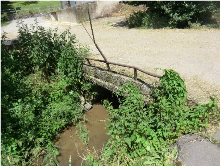
Durchlass; Ufer unterbrochen
