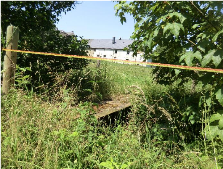
Durchlass; Ufer unterbrochen
