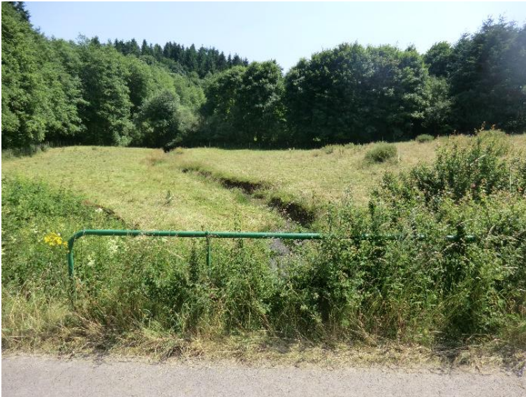
Durchlass; Ufer unterbrochen
