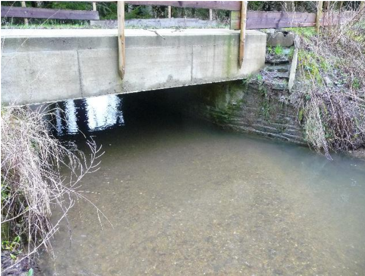
Durchlass; Ufer unterbrochen
