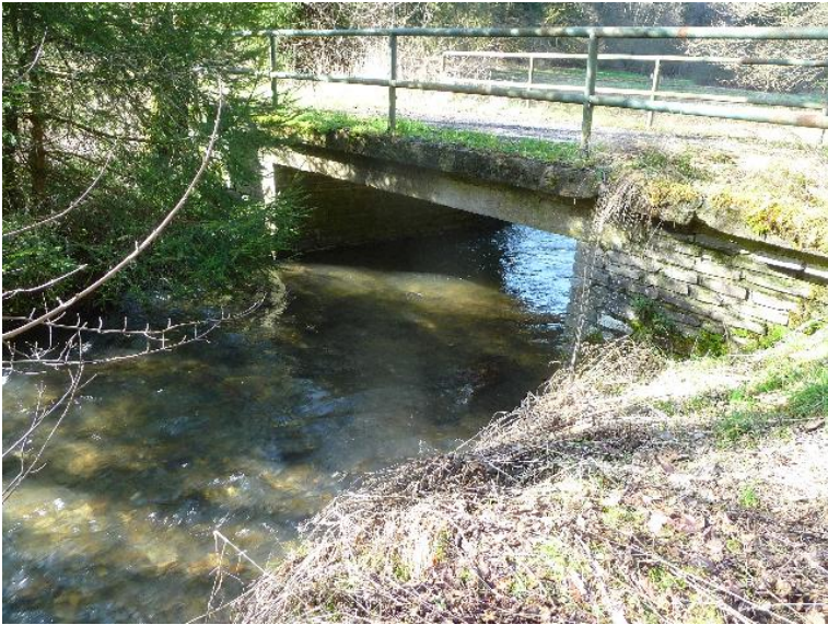
Durchlass; Ufer unterbrochen
