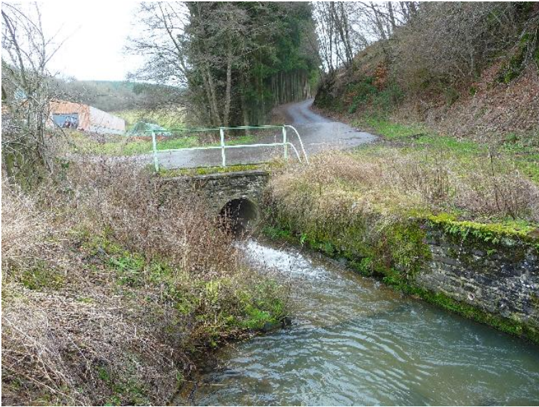
Durchlass; Ufer unterbrochen
