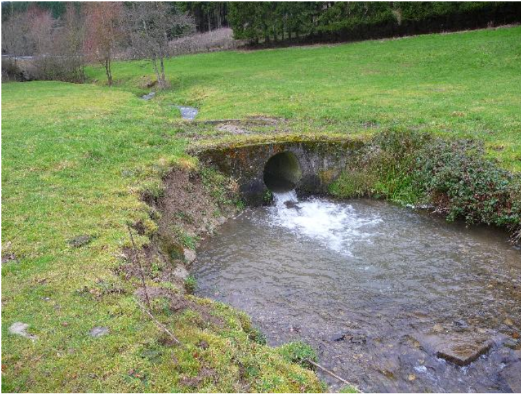
Durchlass; Ufer unterbrochen
