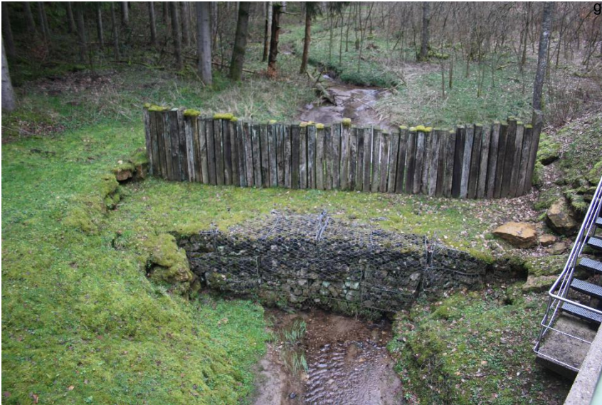
Durchlass; Ufer unterbrochen
